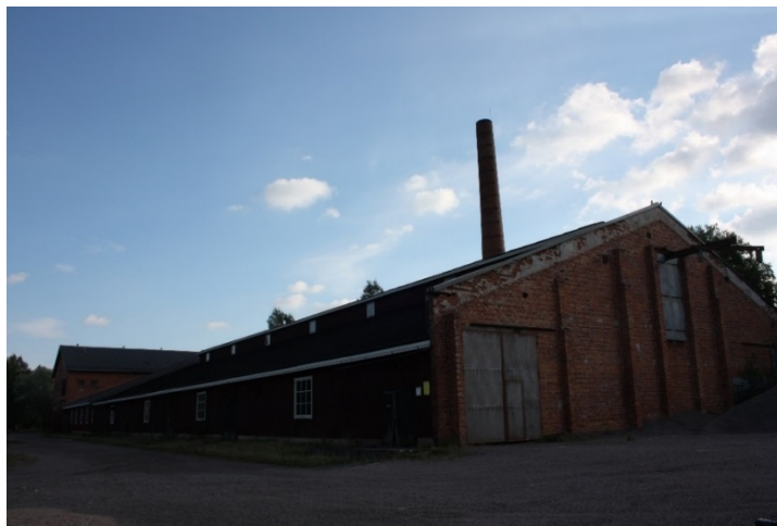
Tiiliuunin suojarakennus vuodelta 1946. Rakennus on suojeltu.
